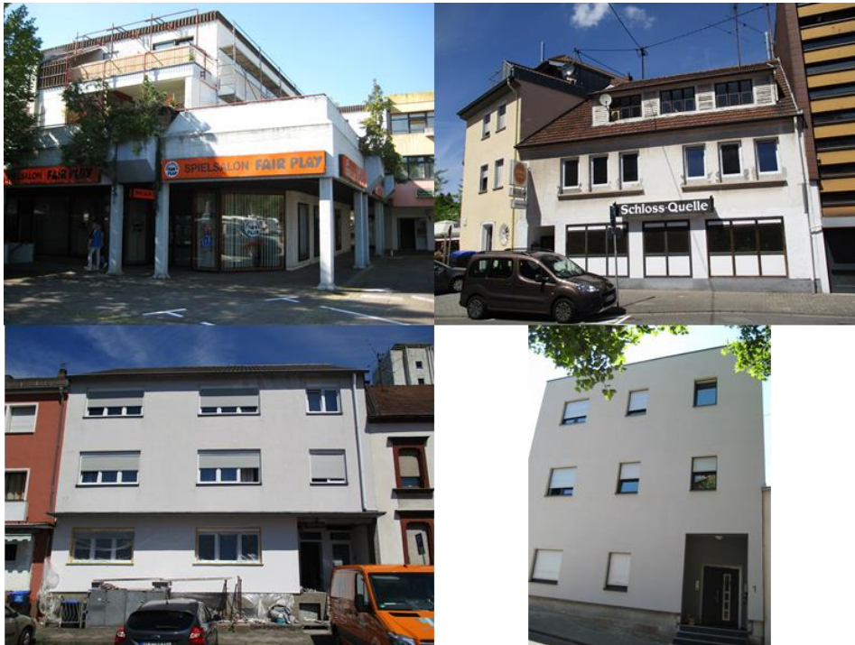
Abbildung 21 Beispiel für Fassadensanierung und Fenstertausch im Bestand (Quelle: Eigene Darstellung, DSK, 2017)
