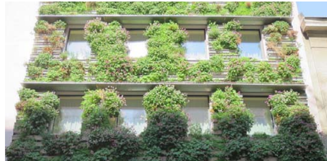
Begrünung mit teilflächigen Vegetationsträgern (Trog-/Kaskadensysteme). Quelle: raintime.at
