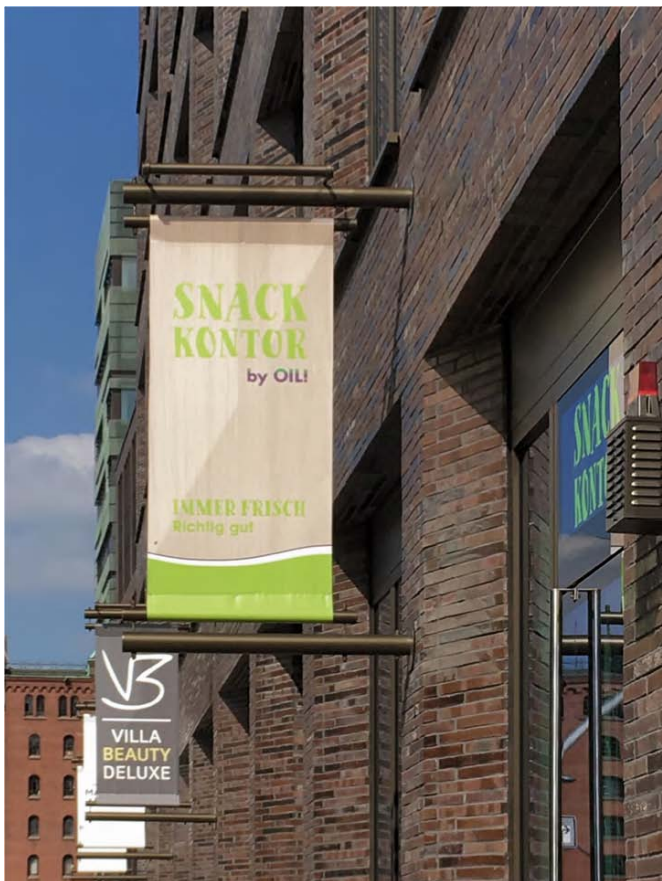
Konstruktion für das Anbringen von Werbebannern im 90°-Winkel zur Fassade. Quelle: hafencity.com
