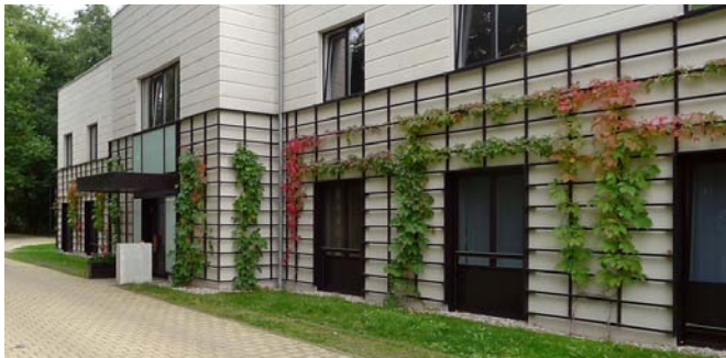
Bodengebundene Fassadenbegrünung mit Holz-Rankgitter. Quelle: fassadengruen.de
