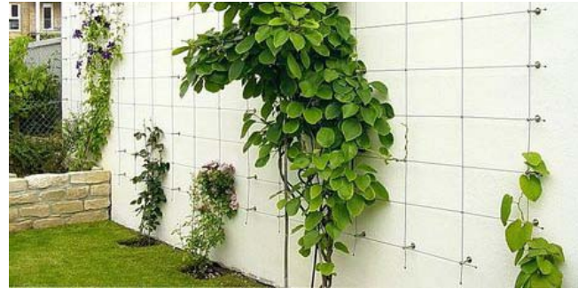
Bodengebundene Fassadenbegrünung mit Seilkonstruktion. Quelle: fassadengruen.de
