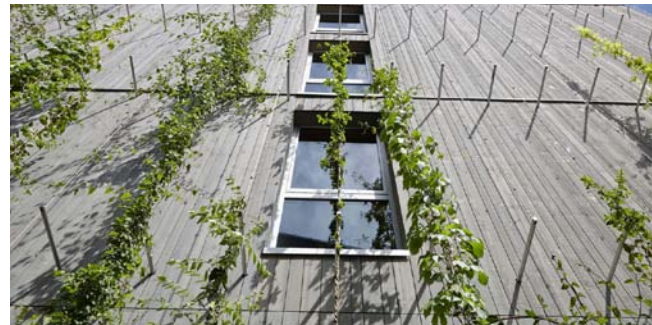
Stahlseilkonstruktion als Rankhilfe. Quelle: baunetzwissen.de, Foto: JakobTrubschachen
