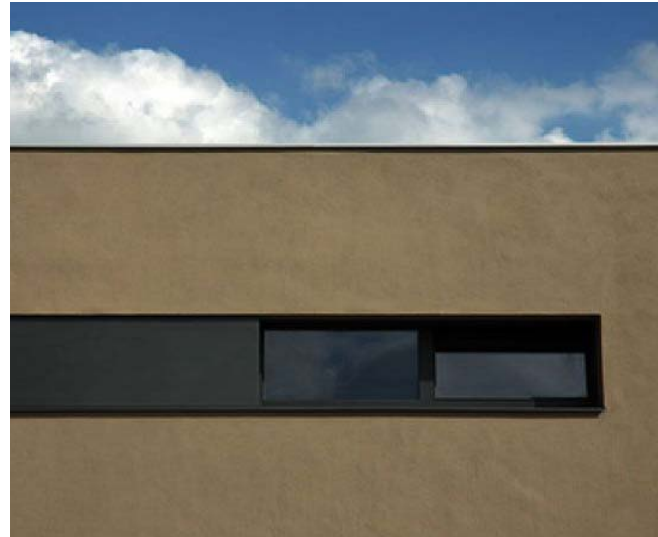
Farblich und strukturell differenzierter Fensterbereich. Quelle: pinterest.at
