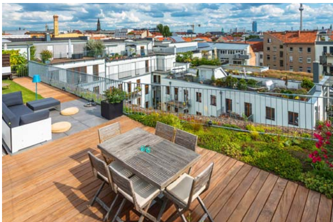
Dachgarten mit hölzerner Terrassenfläche und Stabgeländer zur Absturzsicherung. Quelle: holzhandel-deutschland.de
