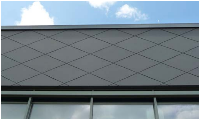
Diagonales Fugenbild. Quelle: bobo-gmbh.de
