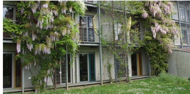
Bodengebundene Fassadenbegrünung mit Gerüstkonstruktion. Quelle: lwg.bayern.de
