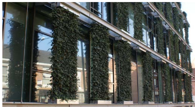
Fassadenbegrünung System Mobilane. Quelle: poliflor.net
