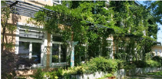
Bodengebundene Fassadenbegrünung mit Pergola. Quelle: umwelt.graz.at, Foto: Werner Prutsch
