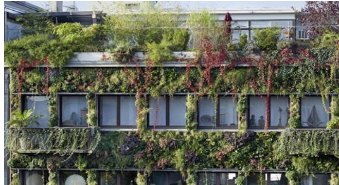
Begrünung Attikazone. Quelle: wallflore.nl
