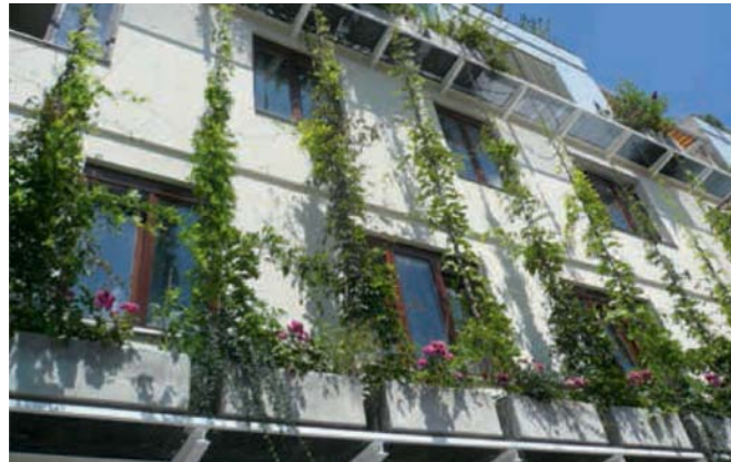
Gemeinschaftshaus B.R.O.T., Wien. Quelle: wien.gv.at
