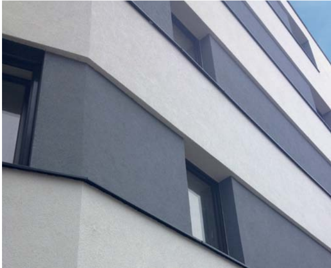
Farblich und strukturell zusammengefasstes Fensterband. Quelle: austrotherm.at
