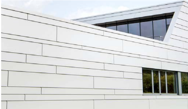
Horizontales Fugenbild. Quelle: schrag-fassaden.de
