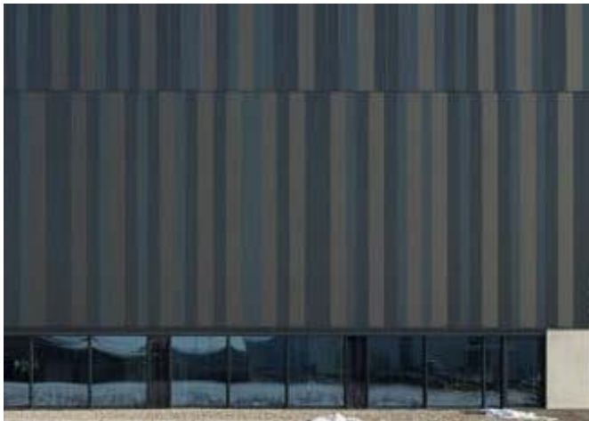
Paneele in drei unterschiedlichen Breiten und jeweils zugeordneten Farben. Quelle: bba-online.de, Foto: Martin Rudau
