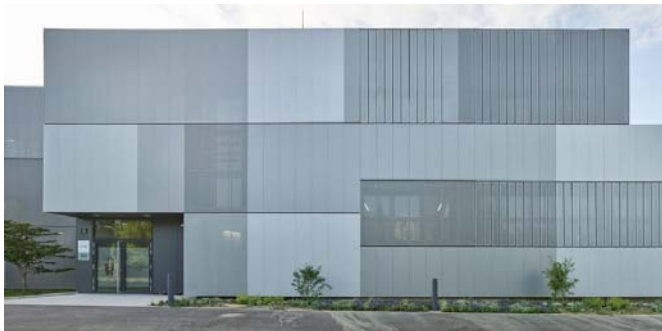
Feuerwache Nord, Linz. Changierende Paneele in Kombination mit perforierten Elementen. Quelle: domico.at
