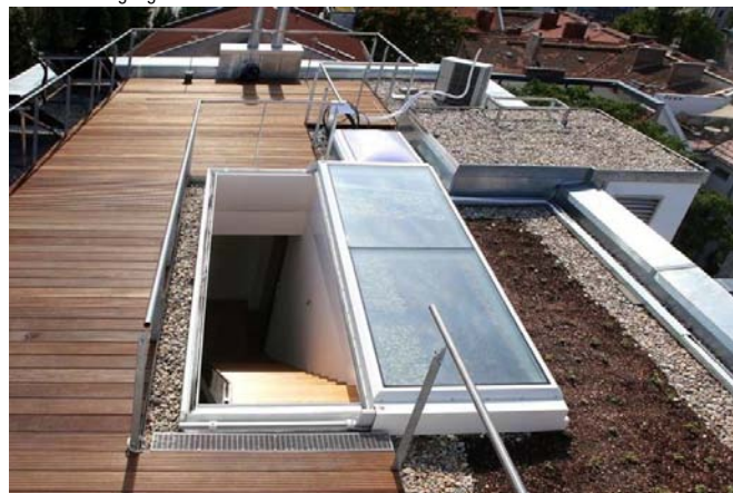
Flachdachausgang zur Terrasse.
