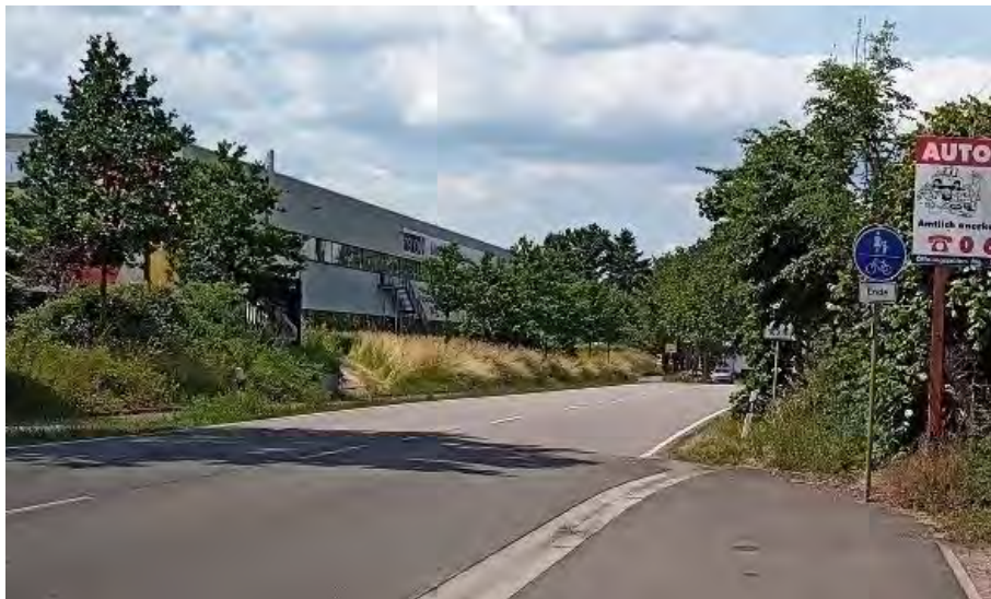
Abb. 18 Radweg endet abrupt ohne Überleitung/Querungshilfe
