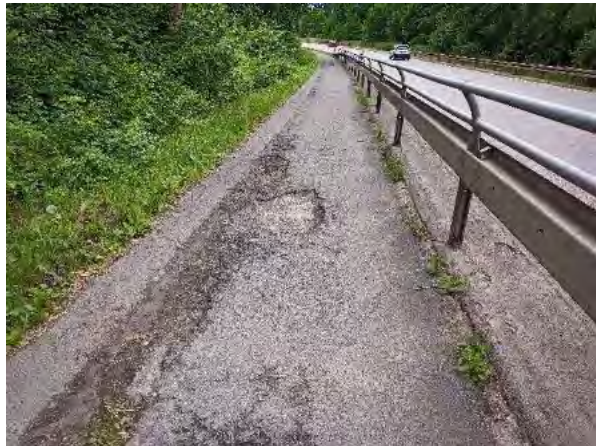
Abb. 17 Deutliche Belagsschäden B268 südlicher Ortsausgang Landsweiler
