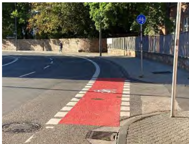
Abb. 10 Radfahrstreifen mit Rotmarkierung im Einmündungsbereich
