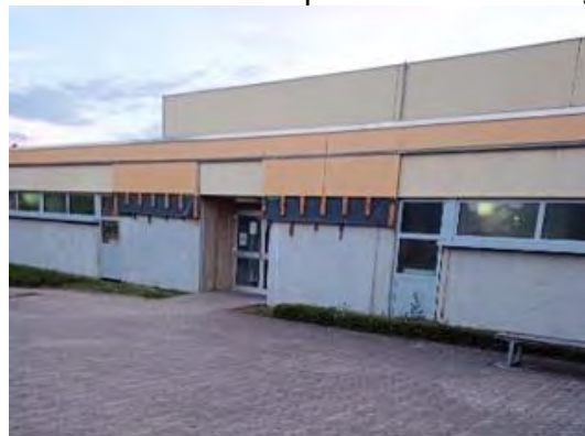
Lebach – Sporthalle an der Ziegelhütte
