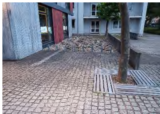
Lebach – Landesamt Dörrenbachstr.
